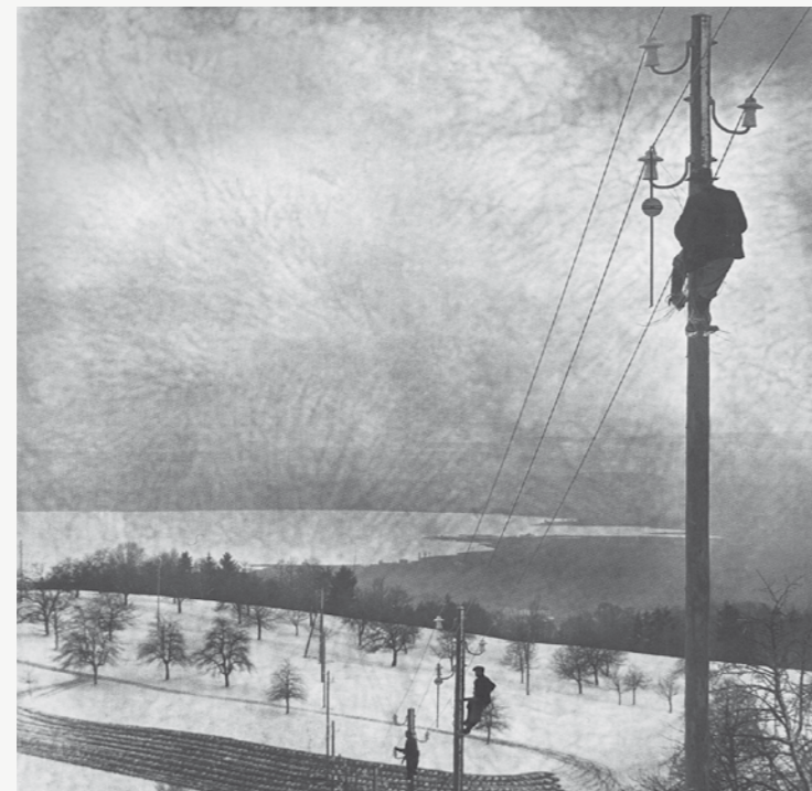
Montage von Freileitungen im Jahr 1915
